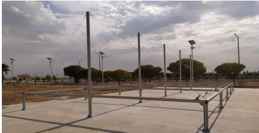
Şekil 29. Fresnel kolektörün alt konstrüksiyon kurulumu
