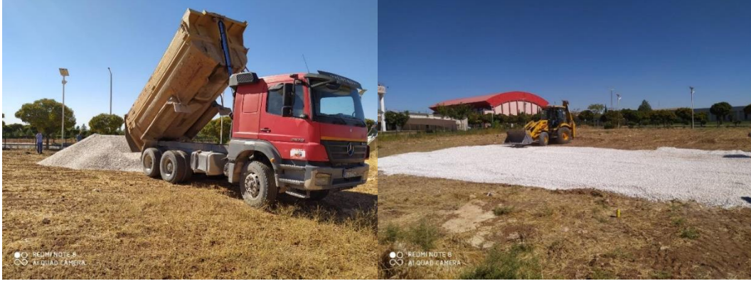
Şekil 4. Toprak zemine çakıl serilmesi
