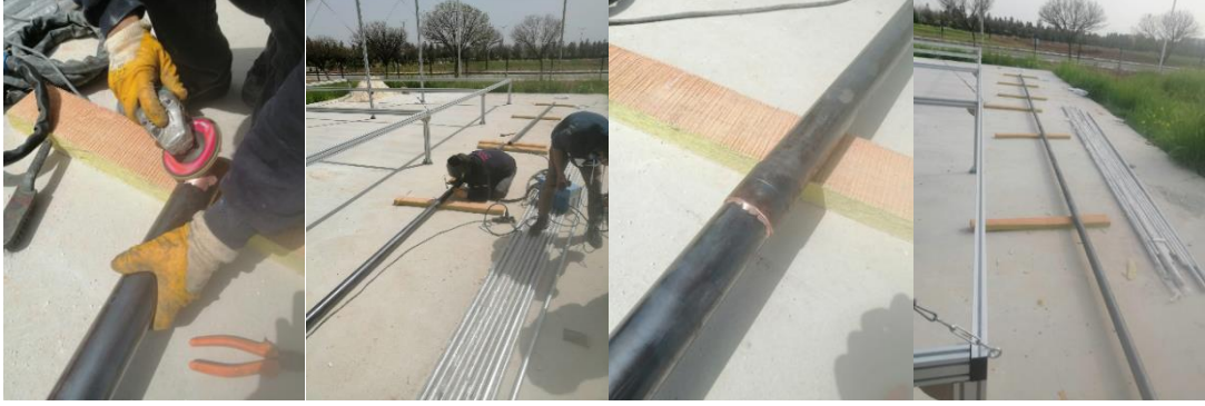
Şekil 54. Absorber boru imalatı çalışmaları
