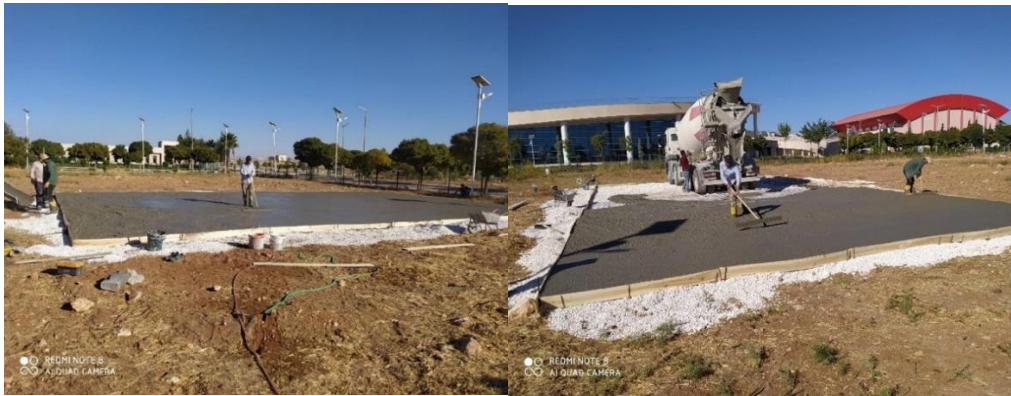
Şekil 7. Sahadan betonlama işlemi görüntüleri
