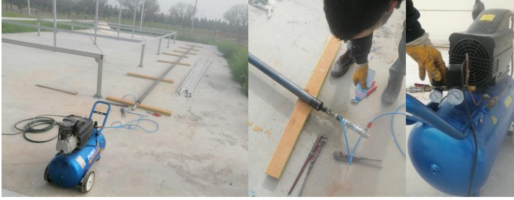
Şekil 55. Absorber boruya sızdırmazlık testi yapılması
