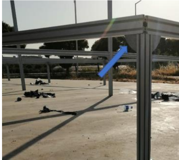
Şekil 15. Prototipte köşe bağlantıların kullanılması
