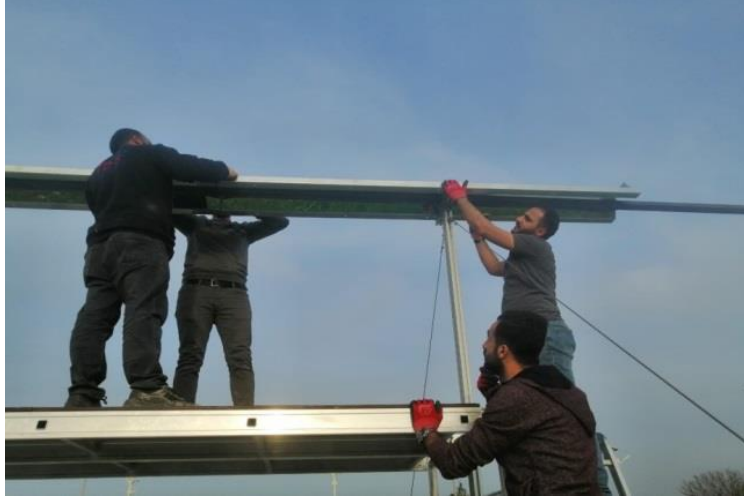
Şekil 62. İkinci reflektörün sahadaki montaj çalışması
