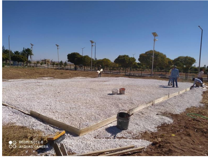
Şekil 5. Zeminde kalıp hazırlama
