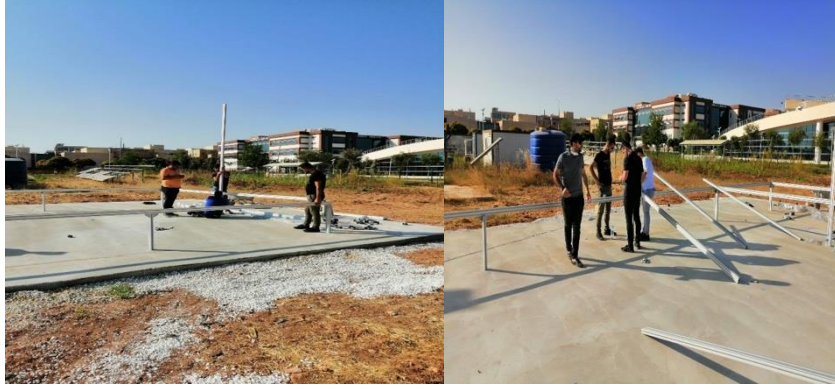
Şekil 28. Lineer Fresnel kolektör konstrüksiyonun kurulumu
