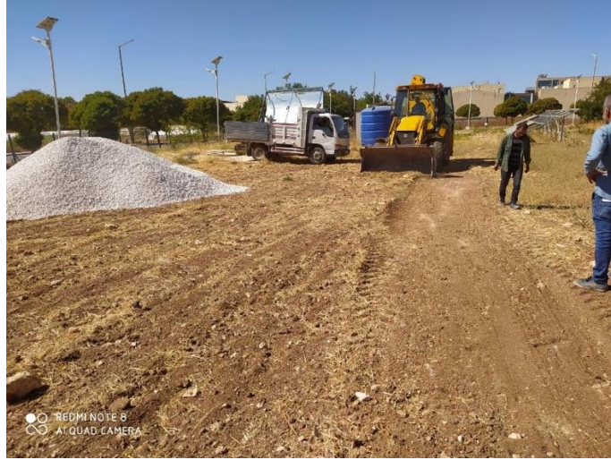
Şekil 3. Zeminin tesviye edilmesi
