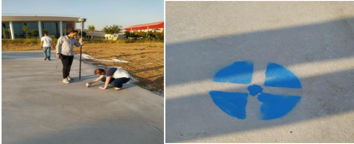
Şekil 11. Ayak noktalarının beton zeminde yerlerinin belirlenmesi
