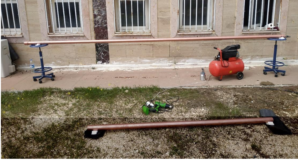
Şekil 48. Bakır boruların kaplama işlemi
