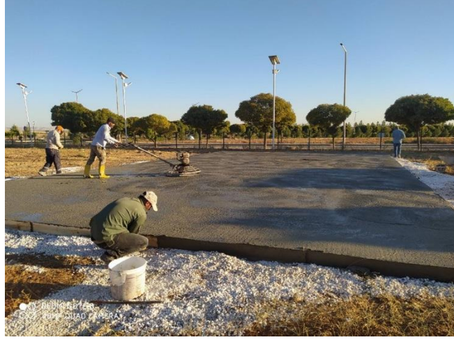
Şekil 8. Betonun yüzeyinin helikopter cihazıyla masterlanması
