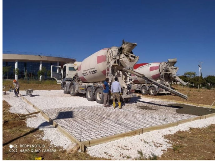
Şekil 6. Kalıp içine hasır demirin bağlanması
