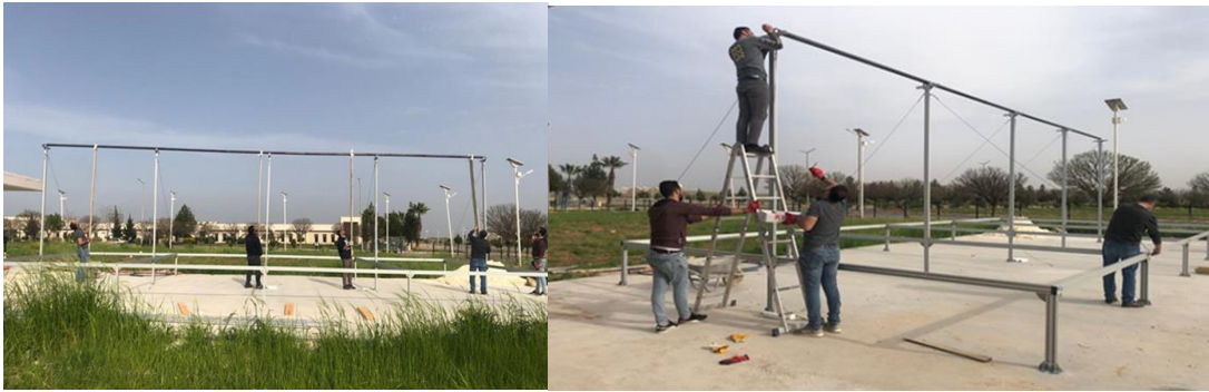
Şekil 56. Seçici soğurucu kaplı bakır boruların güneş kolektörüne montajı
