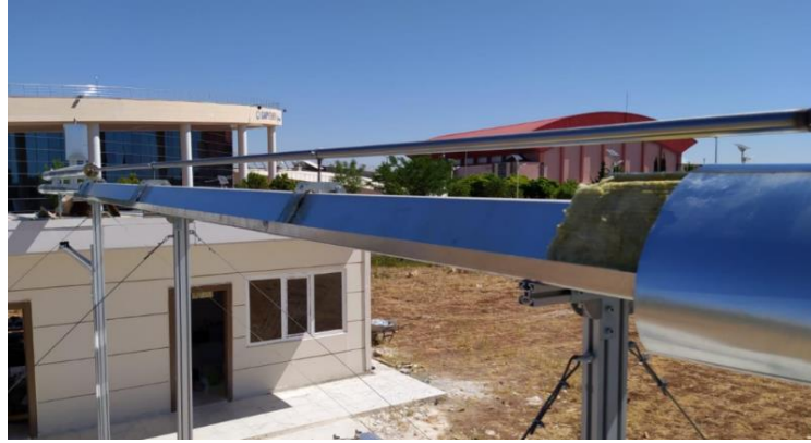
Şekil 63. İkinci reflektöre ısı yalıtımı yapılması
